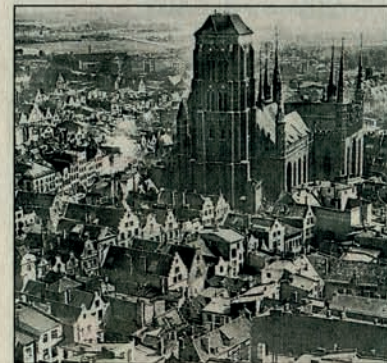
Wie nah Häuser an die Marienkirche gebaut sind, ist zu sehen.
